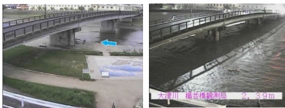
平常時の大津川橋並橋の様子
