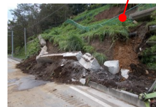
国道299号側面で土砂崩落で集落が孤立 数日間通行止め（熊木町地内）
