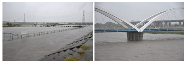
令和元年東日本台風による相模川の増水 (撮影日時：令和元年10月12日午前10時)
