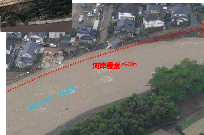
河岸侵食に伴う家屋倒壊等
