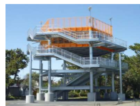
津波避難タワー
