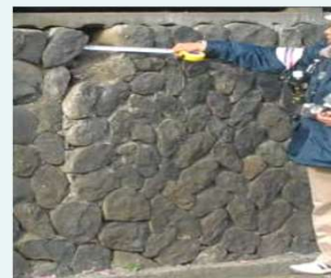
擁壁の危険度調査
