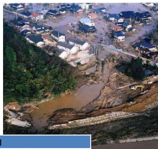
堤防決壊等に伴う氾濫流による家屋倒壊等
