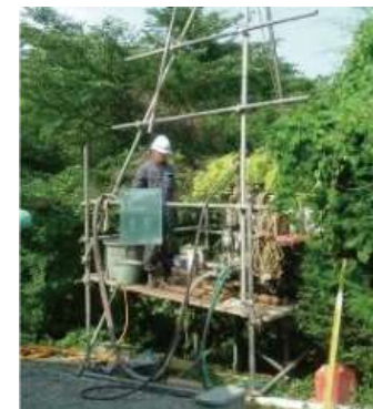
ボーリング調査
