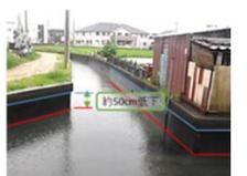
用水路の事前水位低下による雨水貯留
