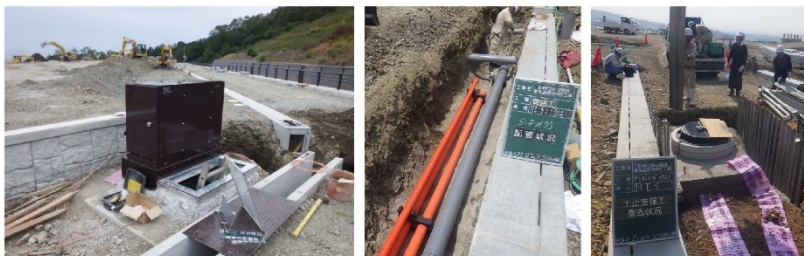
無電柱化整備写真
