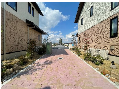
遊歩道内で浅層埋設による地中化 （埼玉県久喜市事例）
