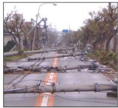
<電柱の倒壊による道路閉塞>
