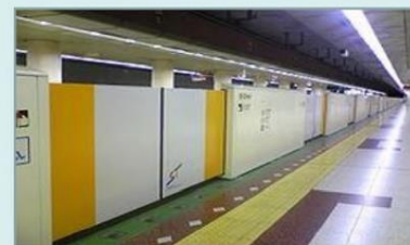
可動式ホーム柵の設置
