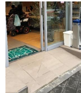
スロープの設置
