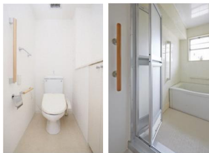
住戸内への手すりの設置
