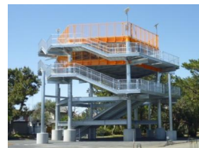
津波避難タワー
