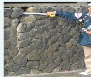
擁壁の危険度調査
