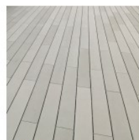
デッキ： 再生木デッキ（グレー系）
