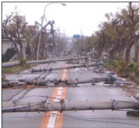
＜電柱の倒壊による道路閉塞＞
