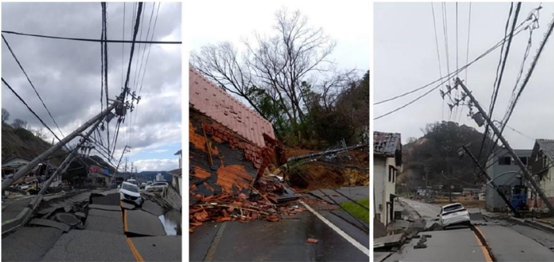
被害状況の事例（電柱の傾斜・折損・混線）
