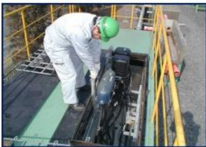
地上での接続作業
