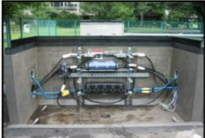
構内での接続作業
