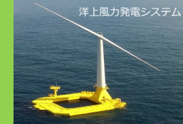
洋上風力発電システム
