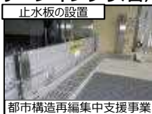
止水板の設置 都市構造再編集中支援事業
