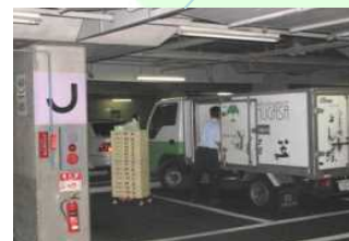
荷捌き駐車場
