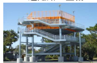
避難タワーの整備
