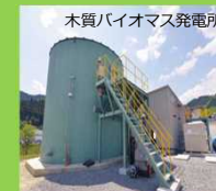
木質バイオマス発電所
