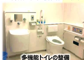
多機能トイレの整備
