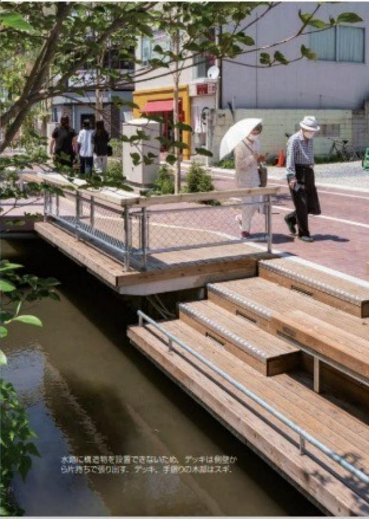
水路に構造物を設置できないため、デッキは側壁から片持ちで張り出す。デッキ、手摺りの木製はスギ。
