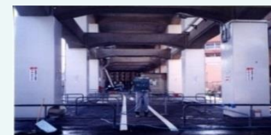
高架橋の耐震対策
