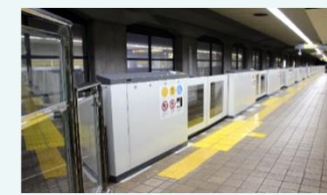
可動式ホーム柵の設置
