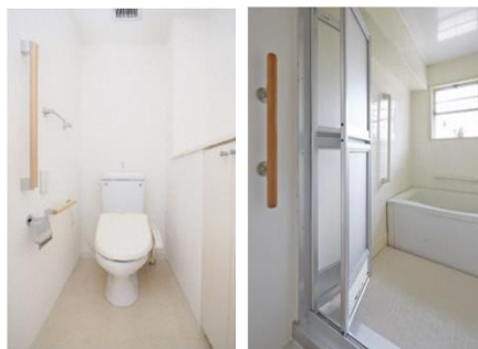
住戸内への手すりの設置
