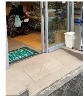
スロープの設置
