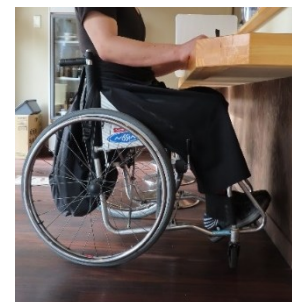
ローカウンターの設置
