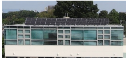
再生可能エネルギー(太陽光)設備
