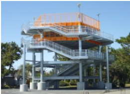
津波避難タワー
