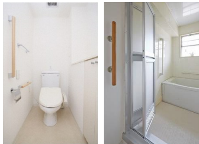
住戸内への手すりの設置
