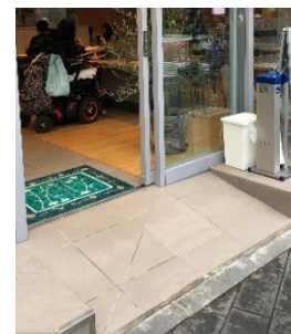
スロープの設置
