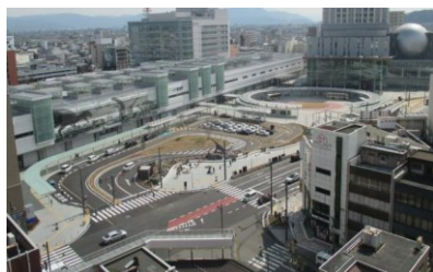
交通結節点整備
