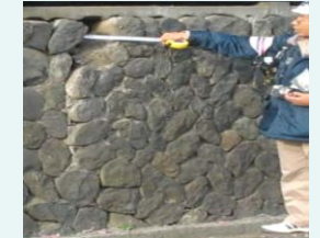
擁壁の危険度調査
