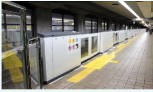
可動式ホーム柵の設置
