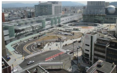
交通結節点整備
