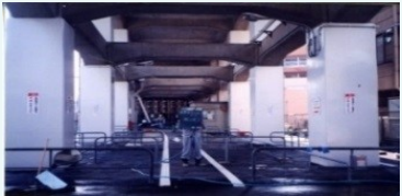
高架橋の耐震対策
