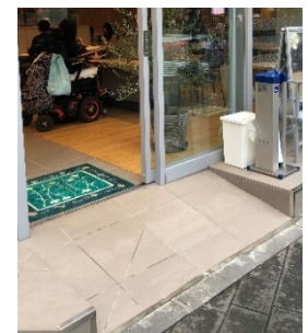
スロープの設置
