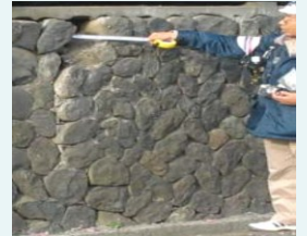
擁壁の危険度調査
