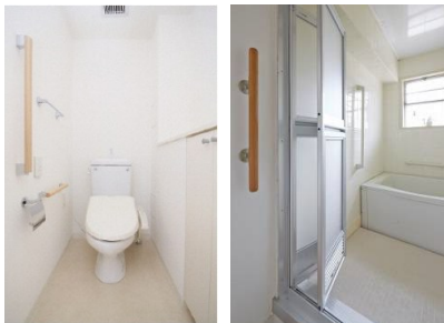
住戸内への手すりの設置
