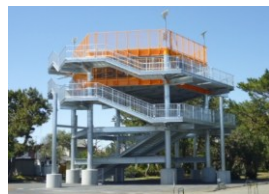
津波避難タワー
