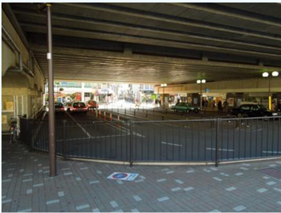
高架下駅前広場の現況(経堂駅)
