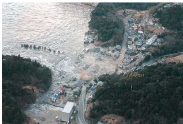
小浜地区 (福島県消防防災航空隊提供)
