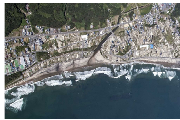
豊間地区 (福島県消防防災航空隊提供)
