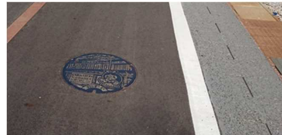
【路側帯のみ美装化箇所と復興版マンホール蓋】
