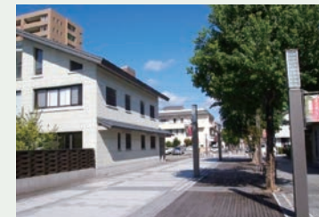
おび通り（島田市） 修景・滞留ゾーンで「木都 島田」にふさわしい木材を使用したデッキ
