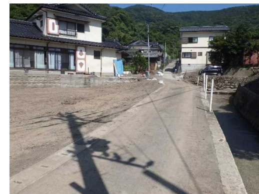
土砂等撤去後(7月29日撮影)
