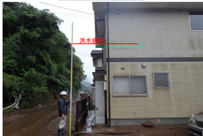
▲過去に宅地かさ上げた家屋が4m程度浸水 出典：国土交通省九州地方整備局八代河川国道事務所HP
