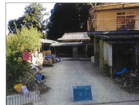
土砂等撤去後(9月29日撮影)
