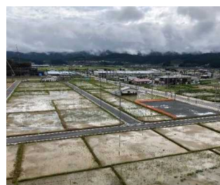
造成宅地の空き区画 (陸前高田市)
