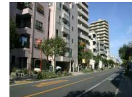
沿道建築物の不燃化
