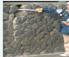
擁壁の危険度調査
