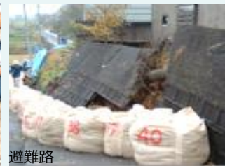
擁壁の防災対策
