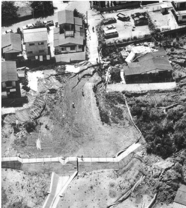
図-1 1978年宮城県沖地震による盛土造成地の被害
