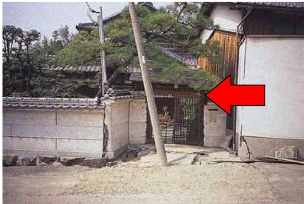
図-1 盛土造成地の変動に伴う被害（西宮市）
