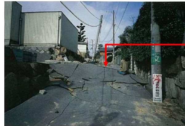
図-2 盛土末端部におけるクラック（西宮市）
