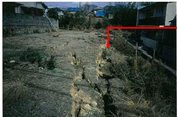
図-1 盛土造成地の変動に伴う被害（西宮市）
