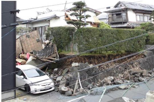
図-1 石積造擁壁の崩壊
