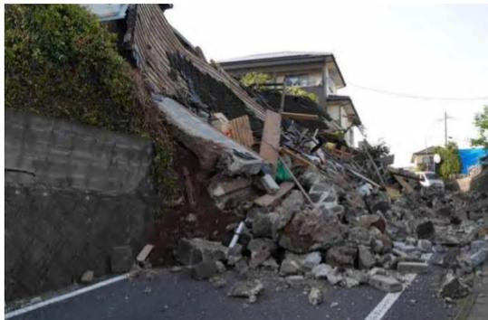
図-3 擁壁の倒壊による生活道の遮断
