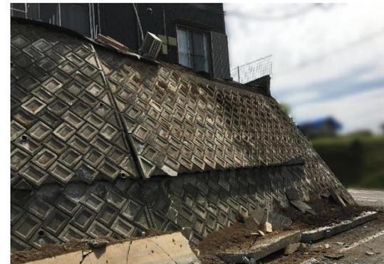
図-4 ブロック積擁壁の段差
