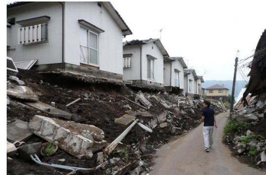
図-2 擁壁の崩壊
