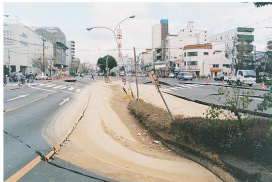
図-3 道路面の変形（兵庫区）
