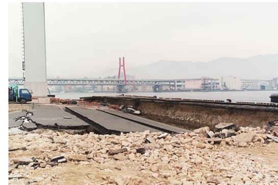
図-4 護岸の前傾・崩壊（東灘区）
