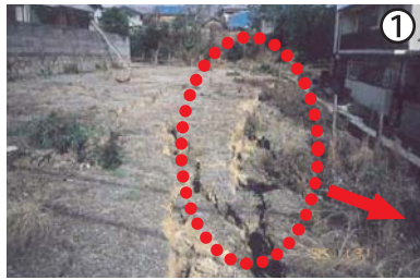
① 写真の矢印の方向に盛土が滑ったために、盛土上部では、地面が引っ張られて亀裂ができています。 (提供:釜井俊孝、守随治雄)
