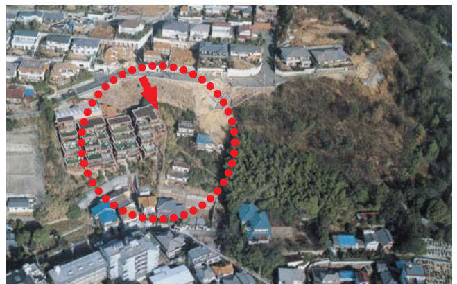
盛土全体が崩れた被害の様子
