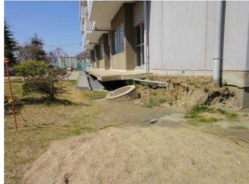
写真3-4 建物の基礎地盤の沈下<sup>6)</sup>
