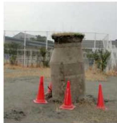
写真 1-2 地下埋設物の浮き上がり
