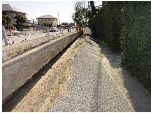
写真3-6 道路側溝の破壊と蓋の乗り上げ<sup>6)</sup>
