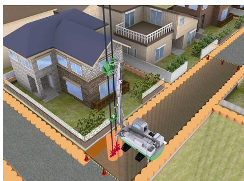
(a) 小型機械攪拌式地盤改良機
