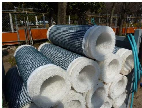
写真5-2 ドレーン管(挿入前、立体網目状集排水管に透水シート、ジオテキスタイルを巻いた状況)
