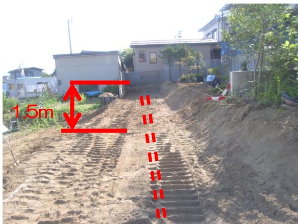
写真-5 暗渠管布設位置
