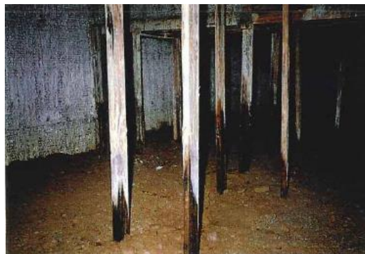
写真-6 建物地下ピット(3) (さん木の状況)
