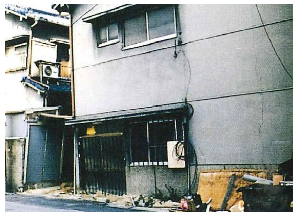
写真-2 建物の沈下状況
