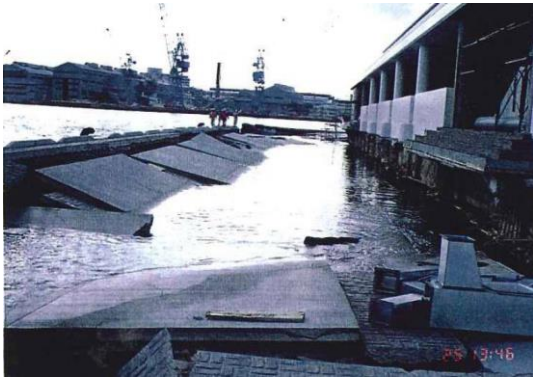
写真-2 埠頭の南側岸壁の被害
