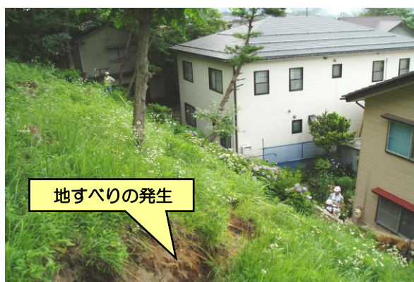
写真-1 砂山の宅地へ地すべり
