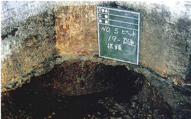
写真-4 建物地下ピット(1) (全体状況)
