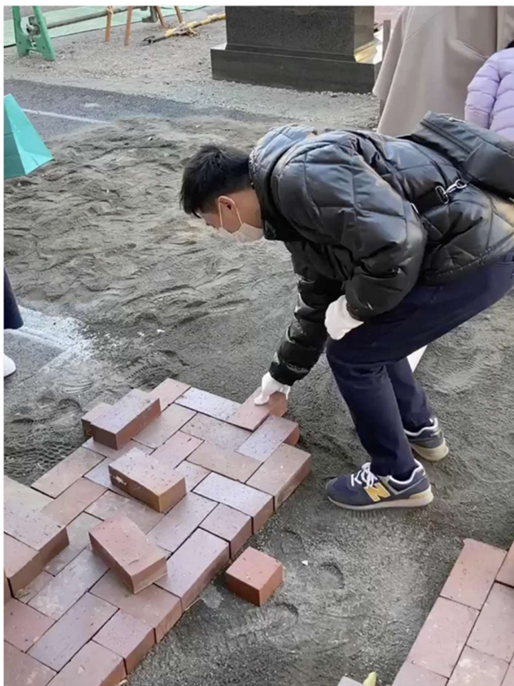
「前橋レンガプロジェクト」レンガ施工体験の様子（ 同社note記事 より）
