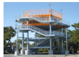
津波避難タワー
