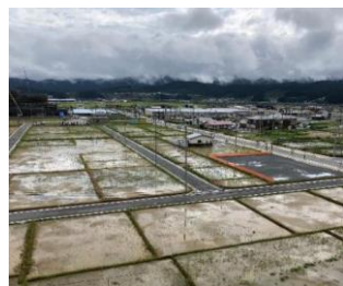
造成宅地の空き区画 （陸前高田市）
