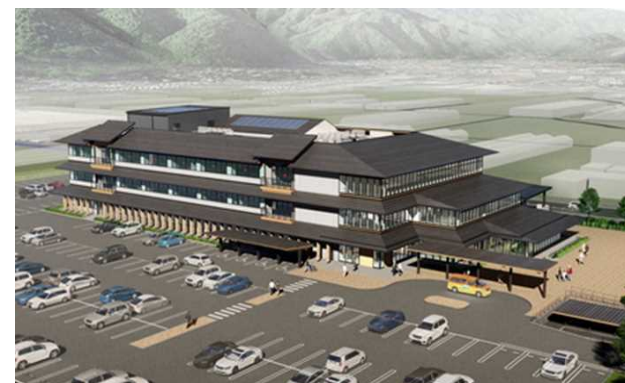
安芸市役所完成予想図（内陸移転） R6完成予定 出典：安芸市ホームページ
