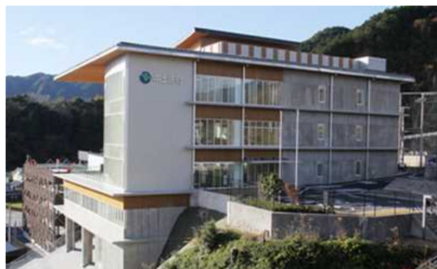
中土佐町役場（高台移転） R2.12竣工 出典：中土佐町ホームページ
