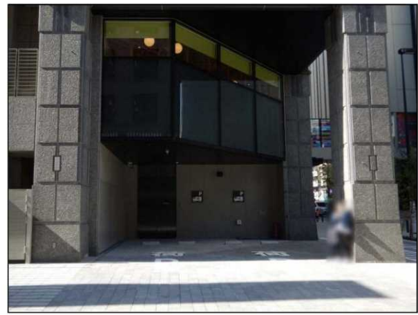
写真4-1 としま区民センター共同荷さばきスペース
