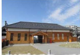
駅舎の地域拠点施設への改修・減築
