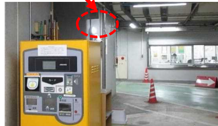
＜発光により、呼出し機能の作動を知らせる装置＞ 81 (名古屋市提供資料)
