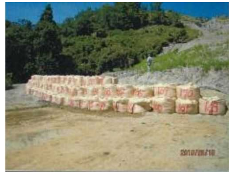
応急対策工事後（大型土嚢）
