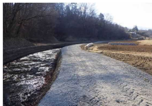
応急対策工事後（流出土砂の撤去）
