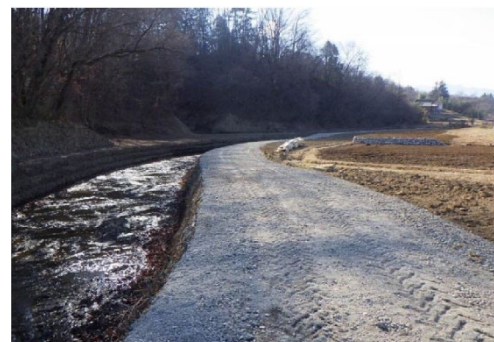
応急対策工事後（流出土砂の撤去）
