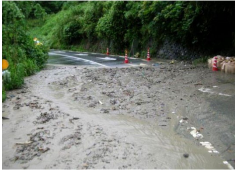
崩落発生後（国道への土砂流出）
