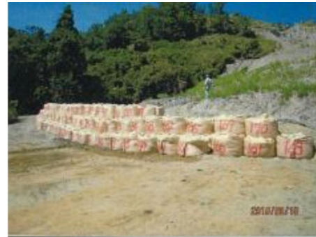
応急対策工事後（大型土嚢）
