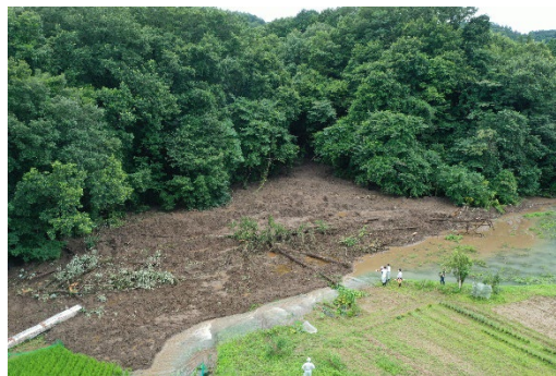
崩落後の土砂流出状況
