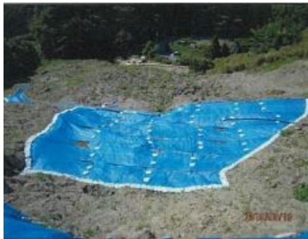
応急対策工事後（ブルーシートによる養生）
