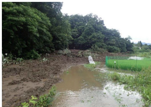
応急対策工事前
