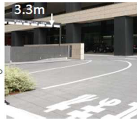
近年は有効梁下高を十分に確保したビルも増加している
