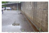
擁壁前面に土砂が堆積
