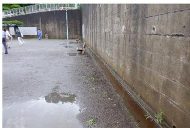
擁壁前面に土砂が堆積
