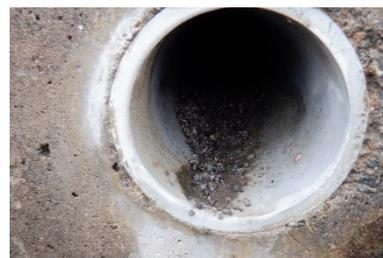
水抜き穴の内部に土砂が堆積
