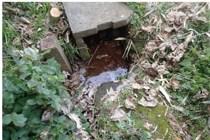
図 3.10 盛土のり尻の排水工からの排水状況確認の例
