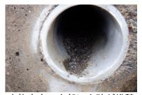
水抜き穴の内部に土砂が堆積
