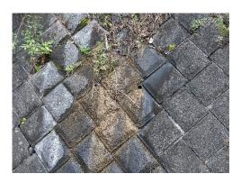
擁壁水抜き孔からの土砂流出
