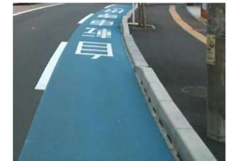
<自転車の走行性に配慮した排水構造の例> 【出典：国土交通省】
