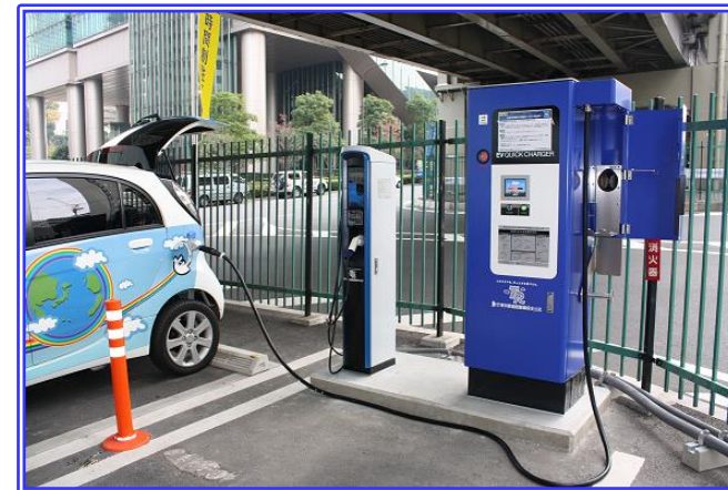
EV充電設備の設置
