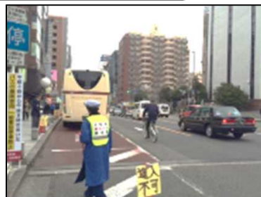
② 交通誘導員の配置
