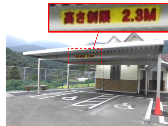
＜車高制限2.3mの屋根付き車椅子使用者用駐車施設＞ (建築設計標準(令和2年度改正版))
