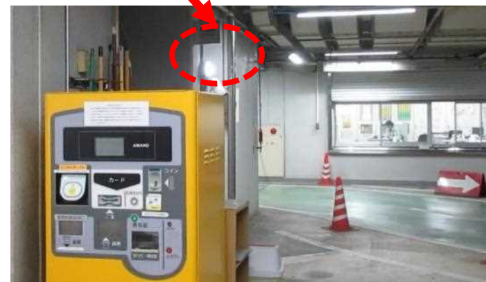
＜発光により、呼出し機能の作動を知らせる装置＞ 91 (名古屋市提供資料)
