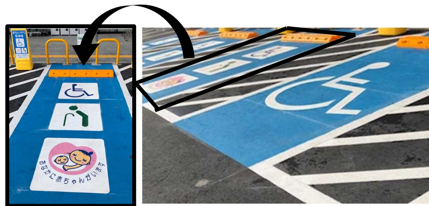
施設管理者の任意の取組（ダブルスペース方式）として、 妊産婦や高齢者を対象に設けた優先駐車区画について、車椅子使用者も駐車できるように幅広な区画として提供している事例
