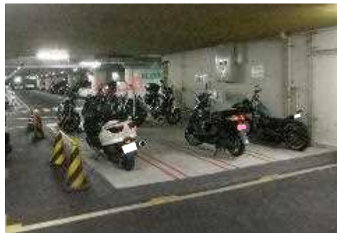
公共駐車場(地下)に整備した事例[京都市]
