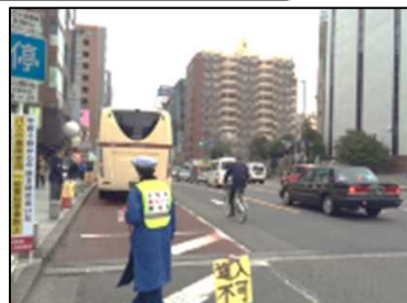
②交通誘導員の配置
