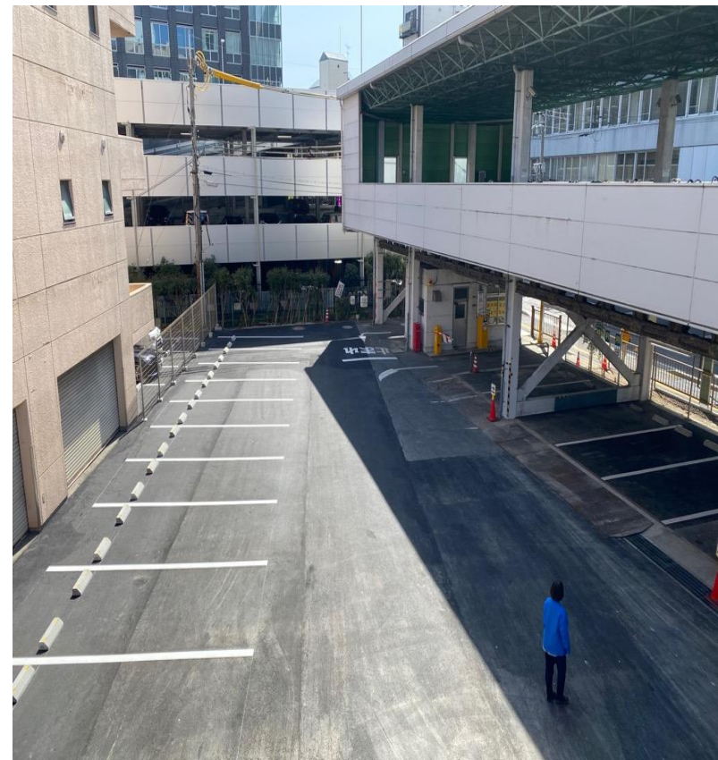
写真：右撤去前、左撤去後
