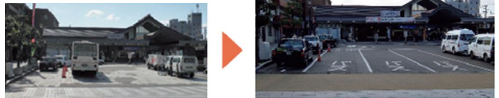
大宰府駅前広場整備事業 駅前広場の舗装化とバス停車帯の設置
