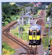
行き違い設備改良
